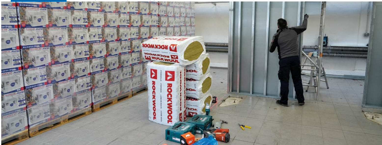
Neues Postverteilzentrum in der Tannenbergallee während der Bauphase.
